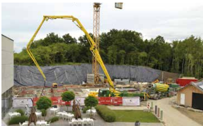
Chantier Neobuild, bâtiment passif à Bettembourg
